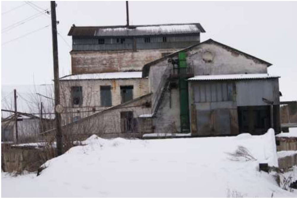
Производственное здание с котельной
